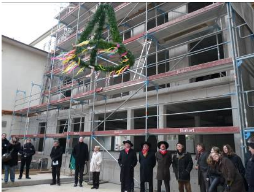
Der Richtkranz im Innenhof des Neubaus.
